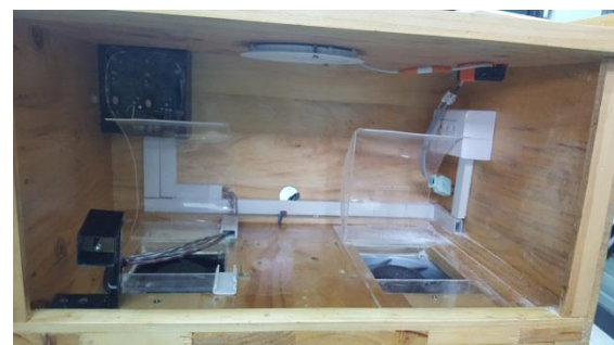
ภาพที่ 5 ภาพทำการติดตั้งอุปกรณ์ไฟฟ้า
