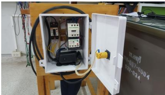
ภาพที่ 7 ภาพทำการติดตั้งชุดควบคุมระบบไฟฟ้า
