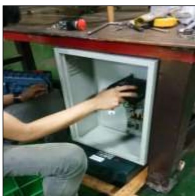
ภาพที่ 6 ภาพการติดตั้งชุดควบคุมมอเตอร์
