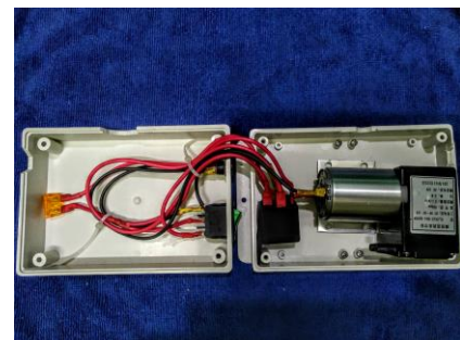
ภาพที่ 5 ภาพแสดงการต่อสายไฟเข้ากับอุปกรณ์ไฟฟ้าควบคุมปั๊มสุญญากาศที่สมบูรณ์
