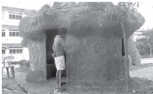
ภาพประกอบที่ 6 ภาพการแกะลายโดยใช้อุปกรณ์ปั้นขูดเซาะตกแต่งผิว
