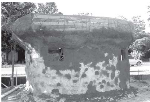
ภาพประกอบที่ 5 ภาพการฉาบผนังโดยสวมถุงมืออย่างป้ายปูนฉาบให้รอบที่มีตะแกรงติดไว้
