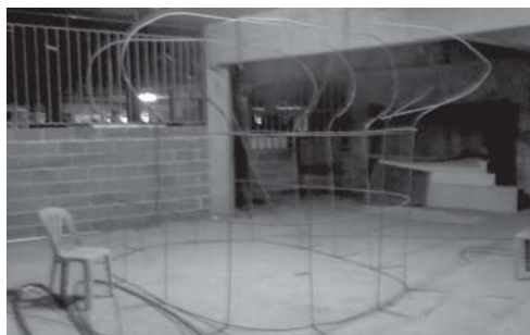
ภาพประกอบที่ 2 ภาพการออกแบบโครงสร้างหินจากการเชื่อมเหล็ก
