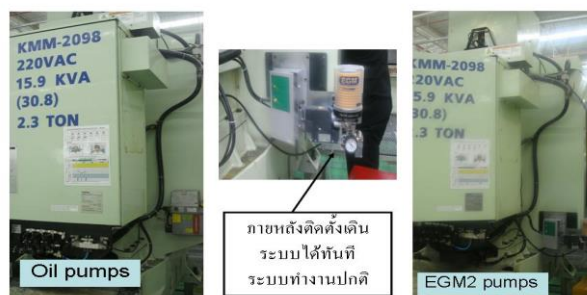
ติดตั้งปั๊ม EGM2 ณ จุดเดิม
