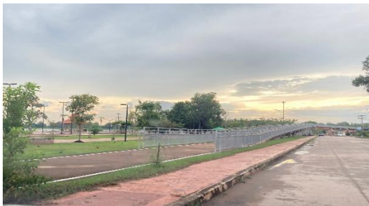
ก. ถนนและช่องทางจักรยานบริเวณสวนสาธารณะ
