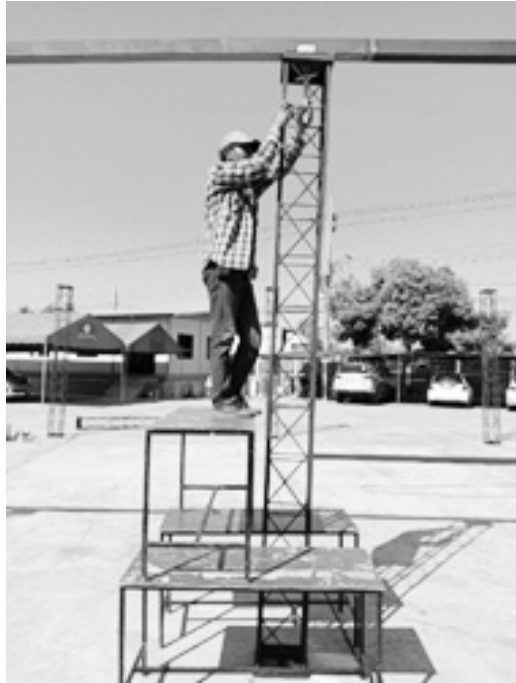
ภาพที่ 5 ประกอบเข้ากับเสาและคานรับหลังคา
