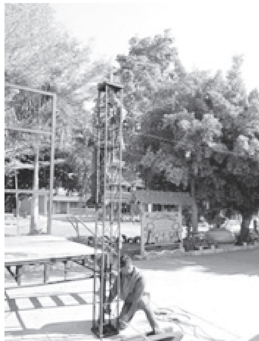
ภาพที่ 3 ยึดด้วยน๊อตกับพื้นและตรวจเช็คระยะ
