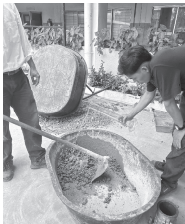
ภาพที่ 11 การเทน้ำเข้าไปผสมกับ วัสดุที่ได้จัดเตรียมไว้
