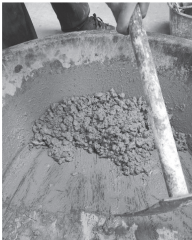
ภาพที่ 10 การผสมวัสดุที่ได้จัด เตรียมไว้ลงในอ่างผสมปูน
