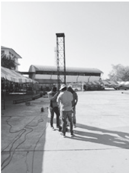
ภาพที่ 2 นำเสามาตั้งตามแนวที่กำหนด
