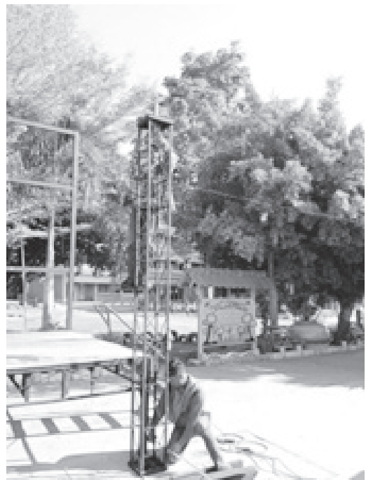
ภาพที่ 3 ยึดด้วยน๊อตกับพื้นและตรวจเช็คระยะ
