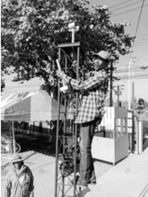
ภาพที่ 4 นำเกลียวปรับระดับมาติดตั้งที่หัวเสา
