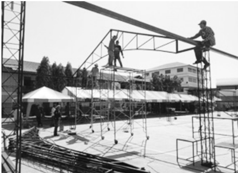
ภาพที่ 6 ประกอบโครงถักหลังคาเข้าด้วยกัน
