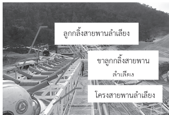
ภาพที่ 2 ส่วนประกอบหลักของสายพานลำเลียง
