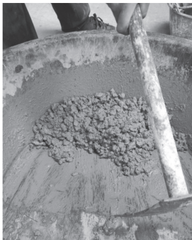
ภาพที่ 10 การผสมวัสดุที่ได้จัด เตรียมไว้ลงในอ่างผสมปูน
