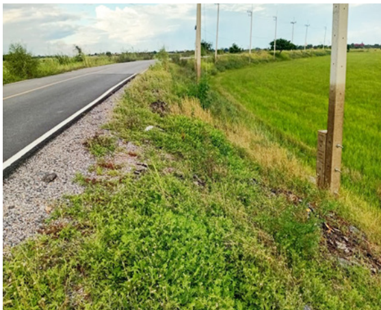
ภาพที่ 10 แนวถนนคันกั้นน้ำที่ถูกยกสูงเพื่อให้สามารถรับน้ำท่วมได้ ผู้เขียน, 30 สิงหาคม 2567
