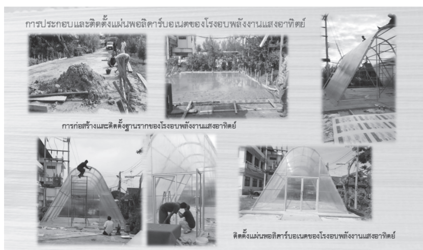
ภาพที่ 6 ขั้นตอนการออกแบบโรงอบพลังงานแสงอาทิตย์แบบพาราโบลา
