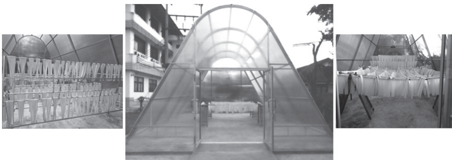
ภาพที่ 7 โรงอบพลังงานแสงอาทิตย์และลักษณะของวัตถุดิบในระหว่างการอบแห้ง
