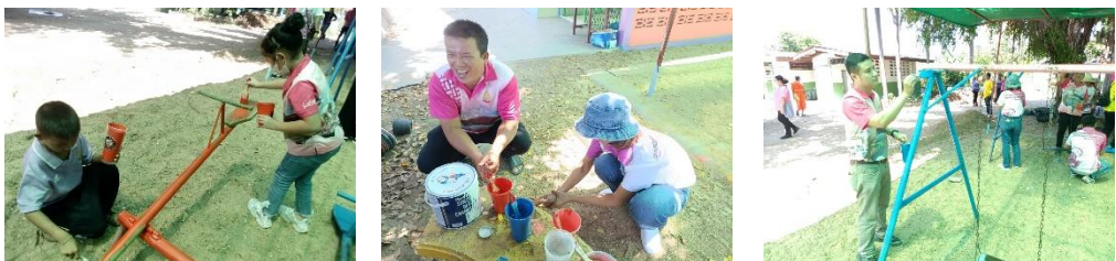
ฐานที่ 1 ปรับปรุงสนามเด็กเล่น โดยการขุดสนิม ทาสีเครื่องเล่น และทำหลังคาสนามเด็กเล่นโดยใช้สแลนสีเขียว เพื่อกันแดดให้แก่ักเรียน
