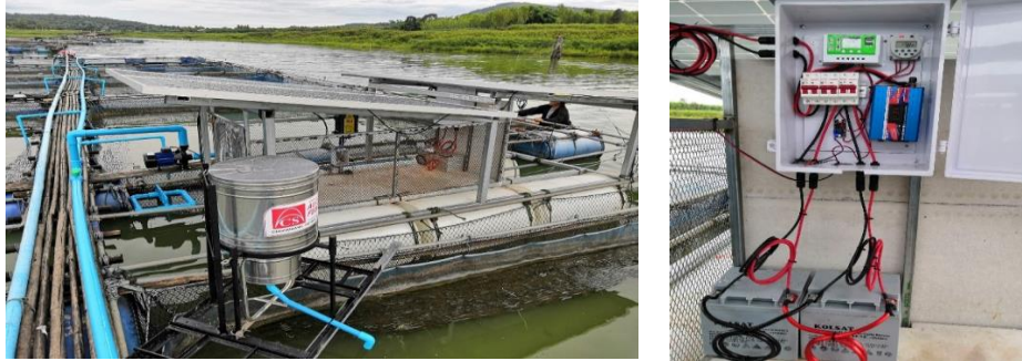
ภาพที่ 1 ภาพรวมของการติดตั้งระบบ
