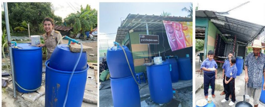
ภาพที่ 3 กิจกรรมติดตั้งระบบผลิตก๊าซชีวภาพจากขยะครัวเรือน
