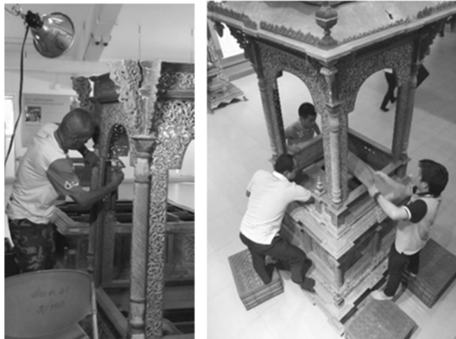
ภาพที่ 7 เสริมความแข็งแกร่งโครงสร้าง ติดตั้งและประกอบชิ้นส่วนที่หลุดจาก ธรรมาสณีให้คงสภาพ
