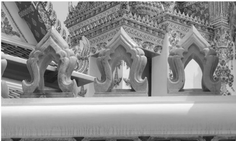
ภาพที่ 12 ซุ้มหินใส่ประทีปทรงเสมาบนกำแพงล้อมพระมณฑป วัดพระเชตุพนวิมลมังคลาราม (ส่วนหนึ่งได้รับการซ่อมแซม)
