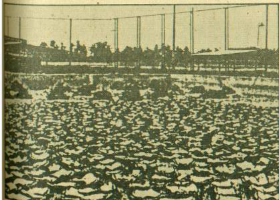
การกำจัดตะกอนอินทรีย์จากระบบ AS บนลานตาก ทราย หรือ Sludge Drying Bed (SDB) ของ โรงงานกระดาษ ปัญจพลไฟเบอร์คอนเทนเนอร์
