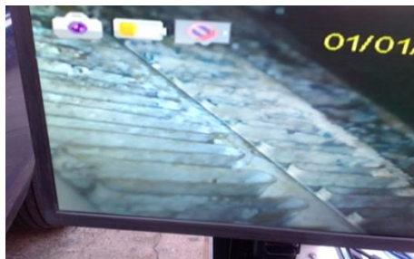
รูปที่ 13 ใช้กล้อง Snake Scope ตรวจสอบทำความสะอาดชุดคอยล์เย็นอีกครั้งผ่านจอมอนิเตอร์ก่อนทำการประกอบอุปกรณ์อื่นๆ
