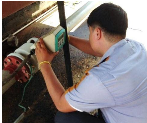
รูปที่ 5 การติดตั้งมิเตอร์วัดการไหลเข้ากับชุดควบคุมปั๊มสูบกากน้ำตาลอัตโนมัติ
