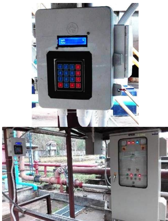
รูปที่ 6 ชุดควบคุมปั้มน้สูบกากน้ำตาลอัตโนมัติ และการติดตั้งในพื้นที่ใช้งานจริง
