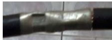
ภาพที่ 4 การย้ายสลิปต่อสายของสายทองแดงกับสาย อลูมิเนียม
