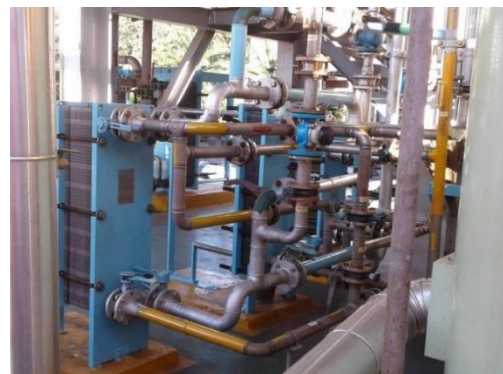
รูปที่ 13 แสดงเครื่องอุ่นน้ำป้อนหลังทำการติดตั้งเข้ากับระบบการกลั่นเสร็จสิ้น
