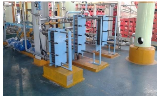
รูปที่ 12 แสดงการติดตั้งเครื่องอุ่นน้ำป้อนเสร็จสิ้น
