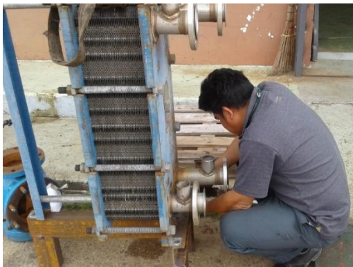
รูปที่ 9 แสดงการเตรียมเครื่องอุ่นน้ำป้อนแบบแผ่น
