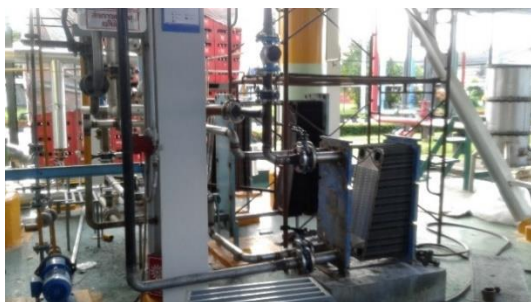
รูปที่ 11 การติดตั้งระบบท่อทางเข้ากับระบบการกลั่นสุรา
