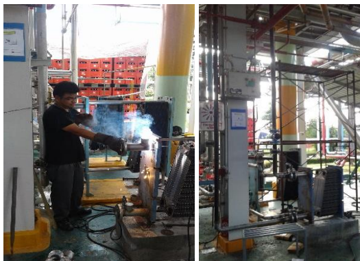
รูปที่ 10 แสดงการติดตั้งเครื่องอุ่นน้ำป้อนแบบแผ่น
