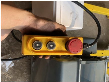
รูปที่ 7 ติดตั้งสวิตช์ควบคุมมอเตอร์ไฟฟ้า
