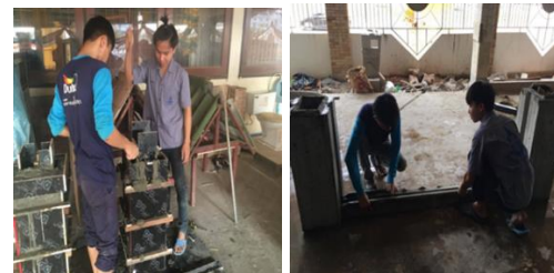
(A) การหล่อเสารั้ว (B) นำคานล็อกด้านล่าง ประกอบเข้ากับเสา
