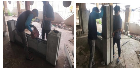
(C) เทมอร์ตาร์เป็น (D) ประกอบตัวประสาน ชิ้นส่วนเสา
