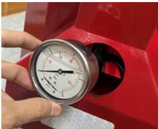
รูปที่ 7 ติดตั้งเกจวัดแรงดันน้ำ
