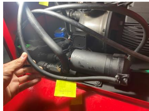
รูปที่ 5 ติดตั้งโซลินอยด์วาล์ว
