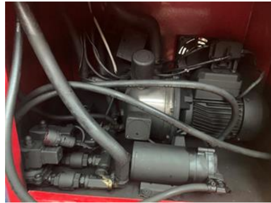
รูปที่ 4 ติดตั้งปั้มนํ้าไฟฟ้า
