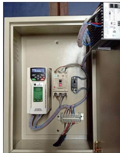
รูปที่ 4 แสดงวงจรภายในตู้ชุดควบคุมอุณหภูมิน้ำพรมกากอ้อยแบบอัตโนมัติ
