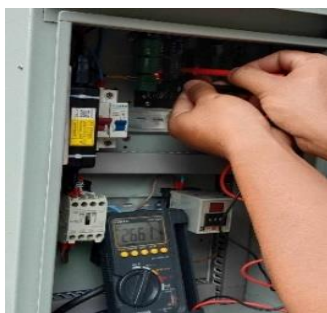
รูปที่ 8 การทดสอบการคำสั่งจากโปรแกรมLabVIEWเพื่อควบคุมการทำงานของมอเตอร์ปั้มน้ำ
