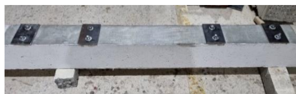
รูปที่ 3 คานเสริมกำลังด้วยแผ่น GFRP ที่ได้รับการติดตั้งตัวป้องกันการหลุดล่อน หรือ คานทดสอบ IEB-3
