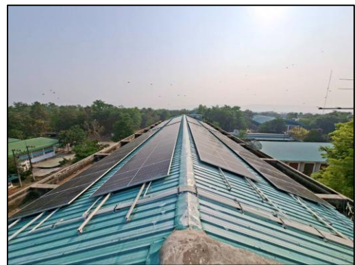
รูปที่ 2 การติดตั้งแผงเซลล์แสงอาทิตย์บนหลังคาอาคารเรียน วิทยาลัยเทคนิคหนองบัวลำภู
