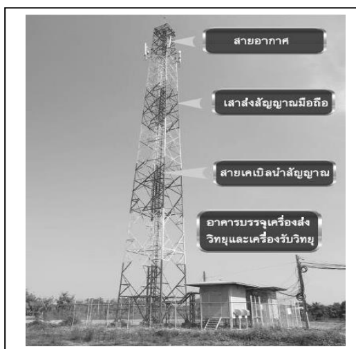
ภาพที่ 1 สถานีฐานของระบบโทรศัพท์มือถือแบบโครงสร้างเสาเหล็ก
