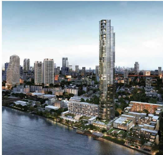
ภาพที่ 2 โครงการก่อสร้างอาคารไฟชีชั้น ไพรเวท เรสซิเดนซ์ สูง 385
