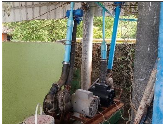
ภาพที่ 2 อุปกรณ์ผลิตออกซิเจนให้กับลูกปู
